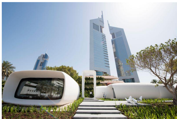
Dubai, famoso edificio realizzato con la stampa 3D (Dubai Government Media Office)
